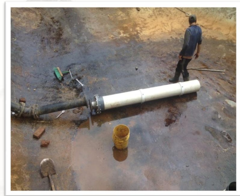
Represa Planta Cetime
