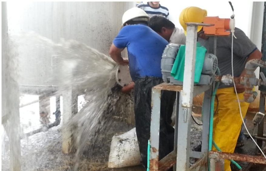
Reparación PTAP Tecniaguas.
