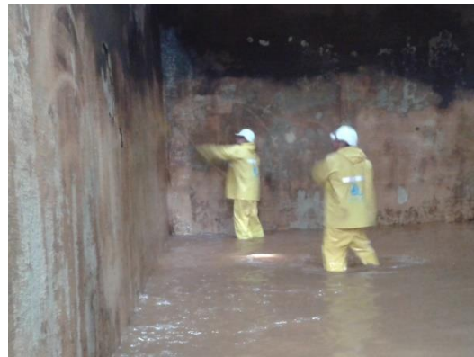
Lavado tanque almacenamiento
