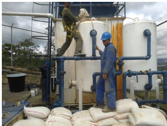
Cambio arenas en filtros
