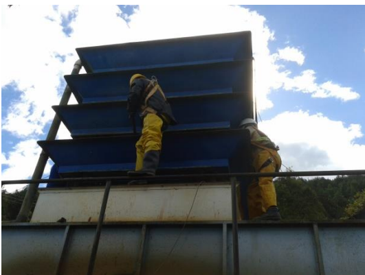
Lavado torre aireación
