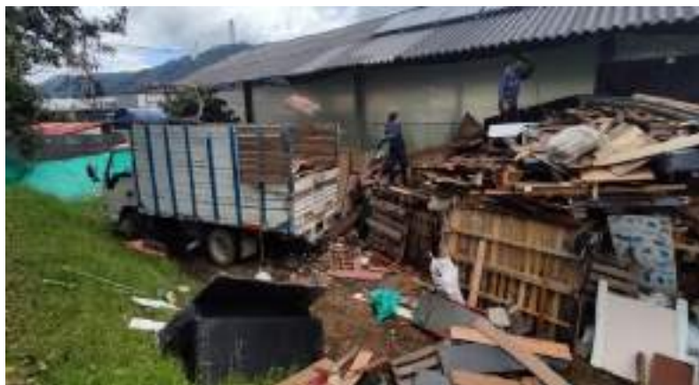
Entrega de madera centro de acopio municipal /01.11.2025
