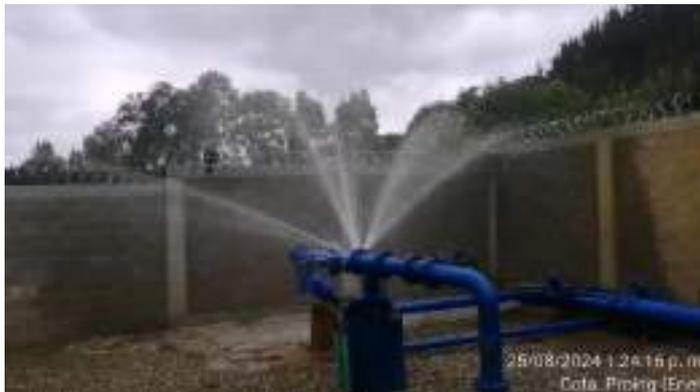
Una vez en sitio se apaga el pozo y se evidencia la ruptura de la válvula por la brida de sujeción
