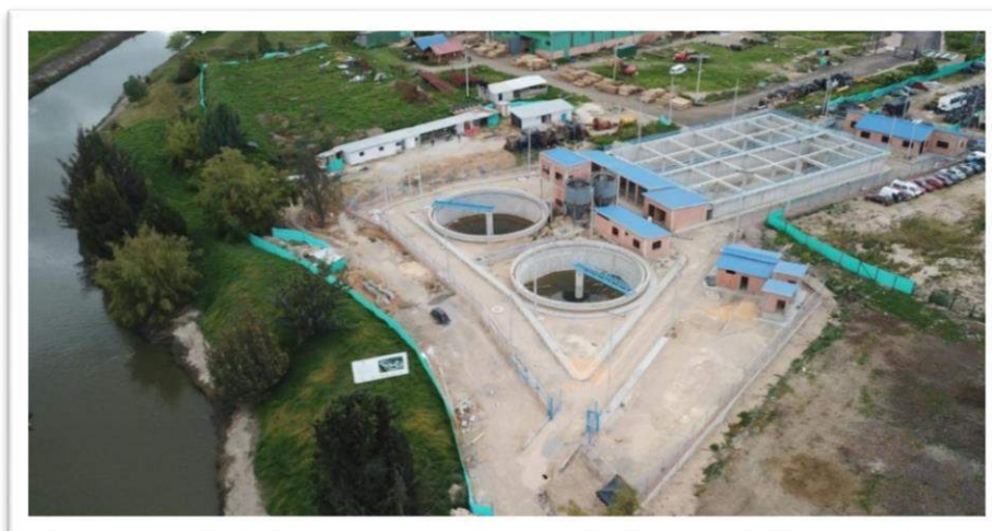
Estado actual de las obras.
