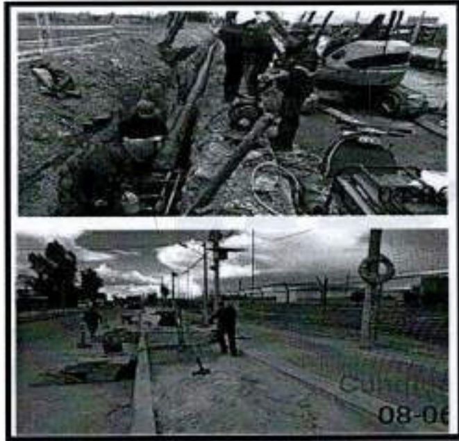
Ilustración 4 Vía parcela sector cancha instalación de tubería. Fuente: ASB
