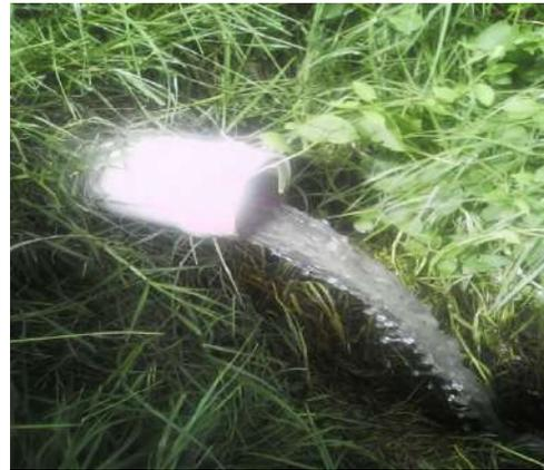
A fin de comprobar que el proceso se esté ejecutando correctamente, se le realiza la toma de muestras compuesta de agua residual al ingreso y la salida de la PTAR de Rozo, labor que es ejecutada por el laboratorio certificado en agua residual, el cual reporta que en la vigencia 2017, los parámetros de Demanda Bioquímica de Oxígeno ( $DBO_5$ ), Demanda Química de Oxígeno (DQO) y Solidos Suspendidos Totales (SST) presentaron la siguiente evolución:
